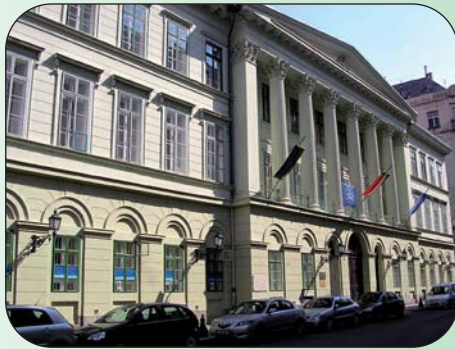
A Megyeháza Városház utcai főhomlokzata
